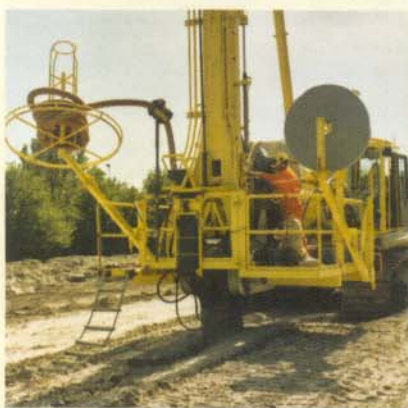
BeauDraininstallatie in bedrijf
