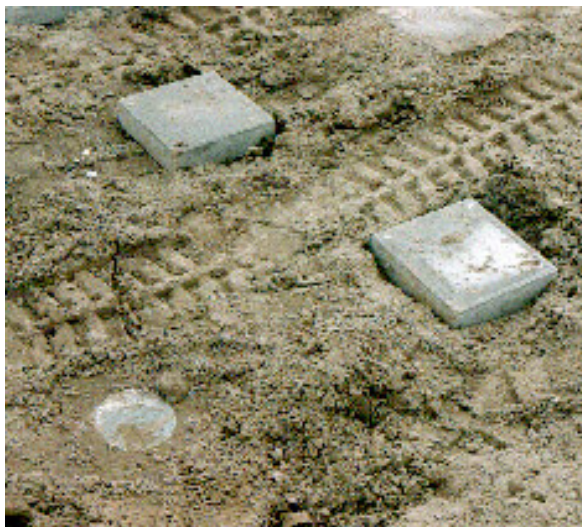
Afgezaagde paalkop met betontegel 300 mm
