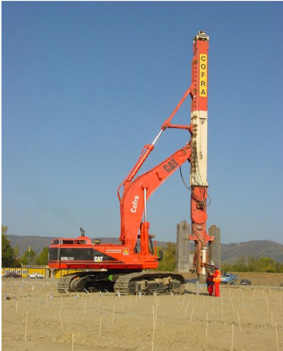
Obr. 3 Aplikácia geodrénov MebraDrain ®
