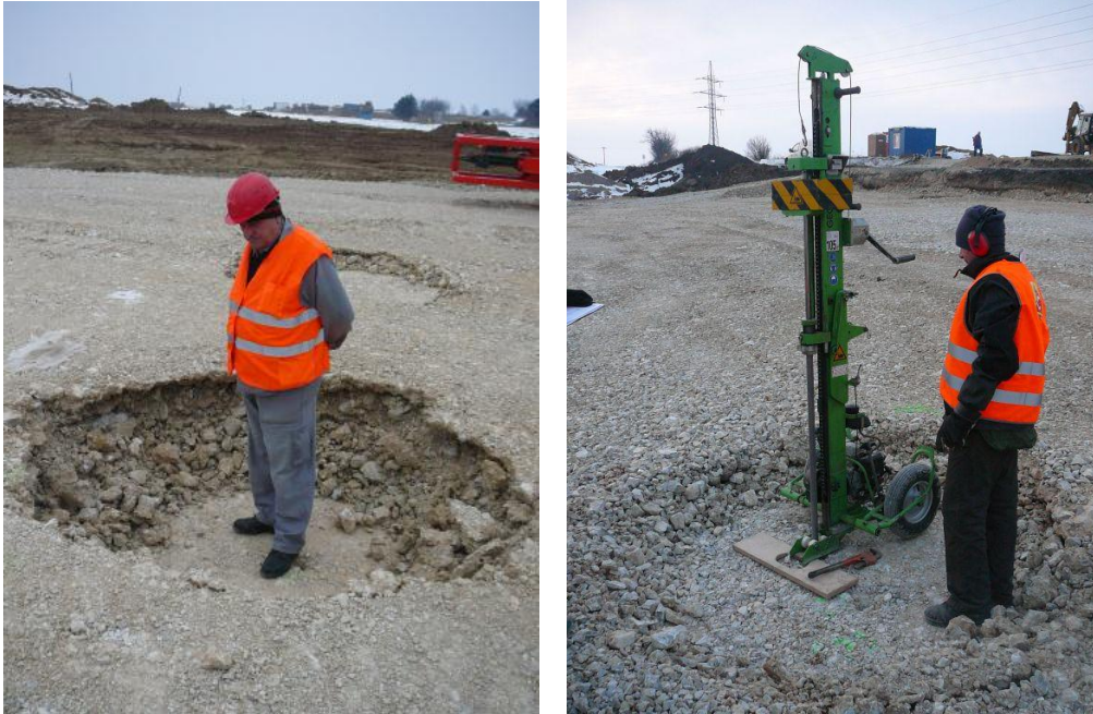
Obr. 7 Depresia po 70 úderoch a kontrolná skúška dynamického hutnenia
