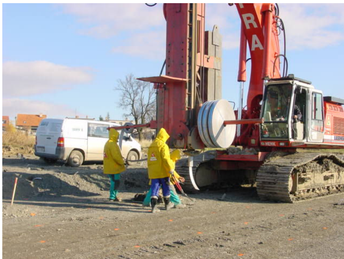
Obrázok 1. Inštalácia Mebradrainu
