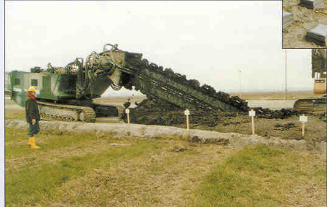
FMI machine voor het maken van een gestabiliseerde grondwand in HW3.
