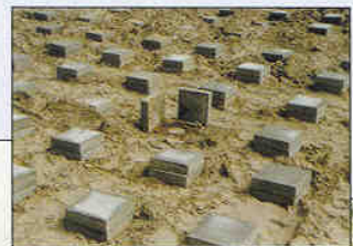
Beton-tegels dekken de palen af in HW5.
