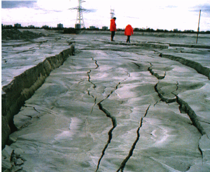
foto: scheuren in het zandpakket
