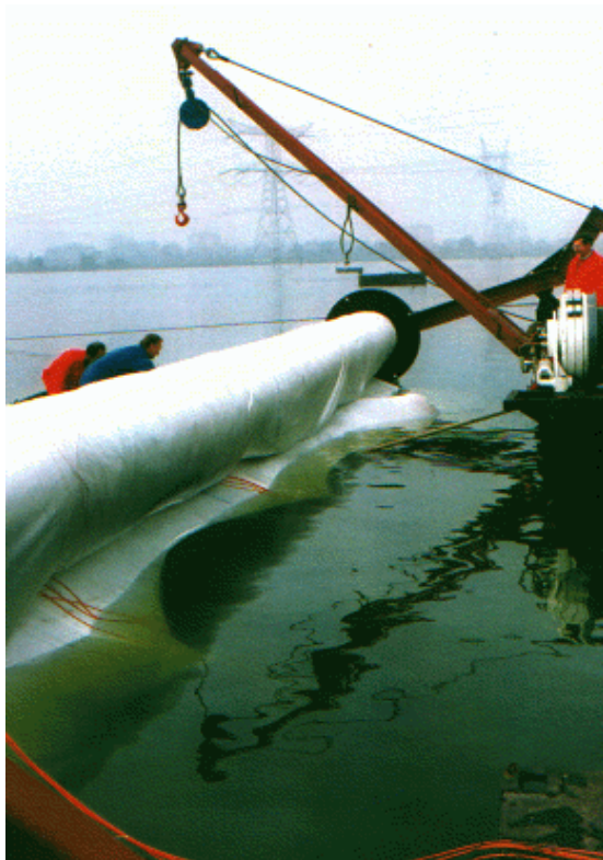
Afrollen van een geotextielmat
