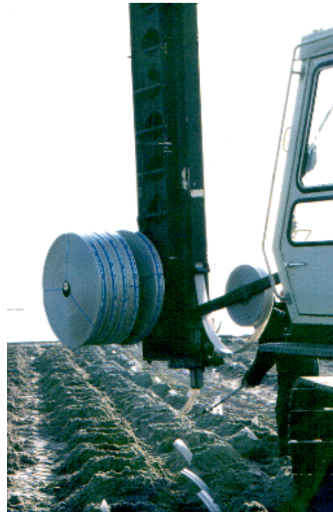
aanbrengen van de verticale drainage
