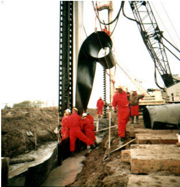
Figuur 4 Installatie Geolock panelen
