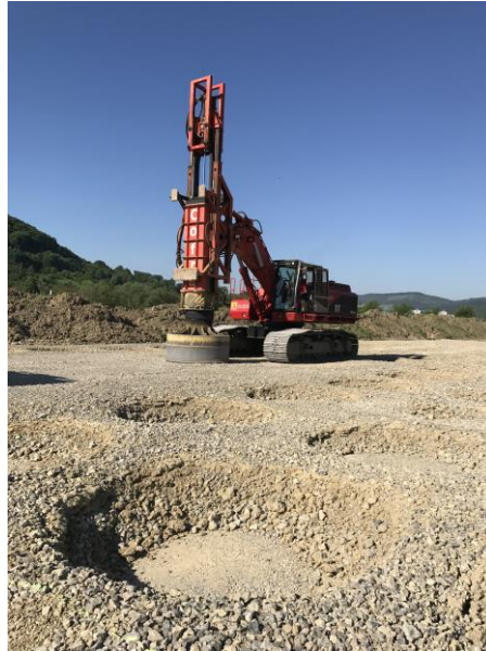
Obr. 1: Zariadenie potrebné pre realizáciu dynamického hutnenia
